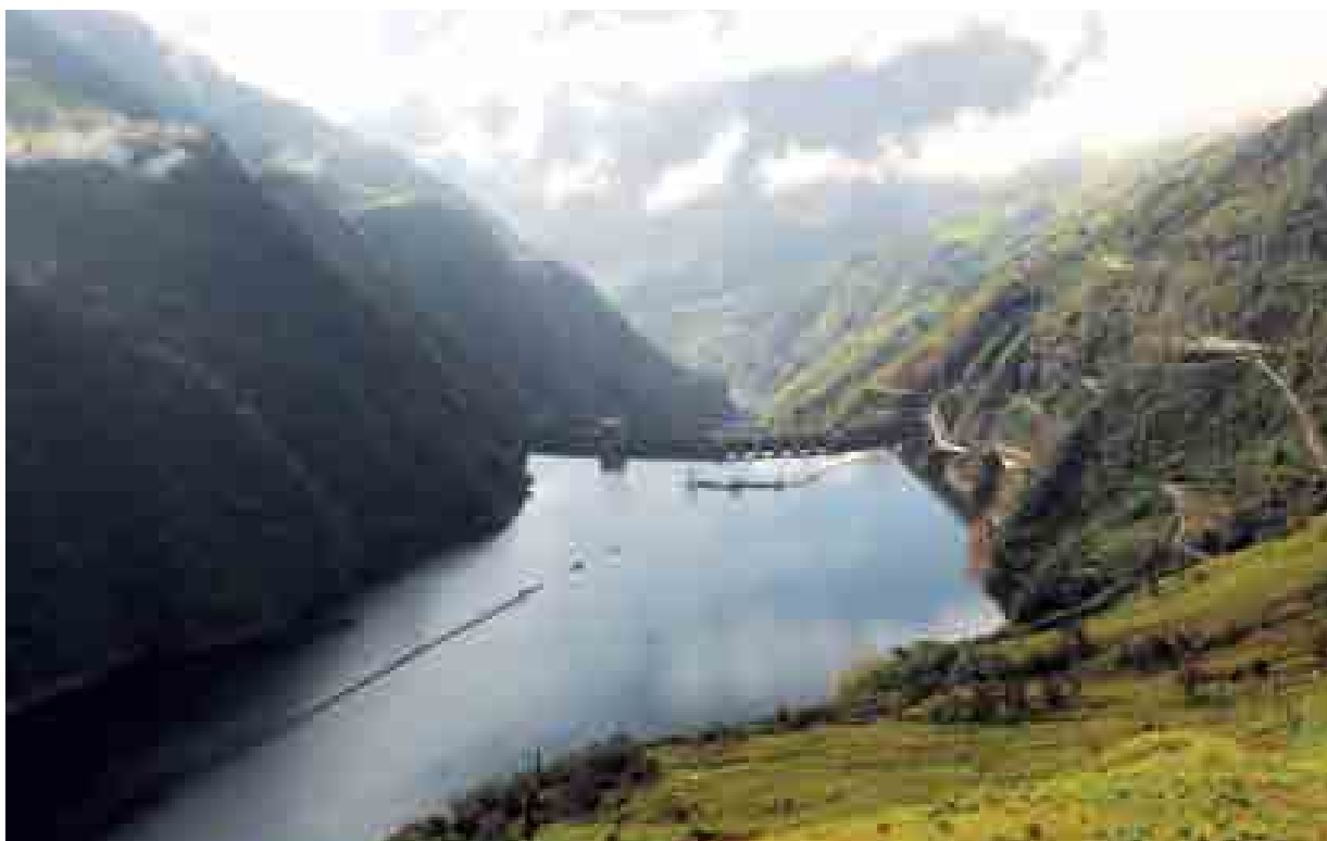
Embalse Amaluza - Hidroeléctrica Paute - Azuay
